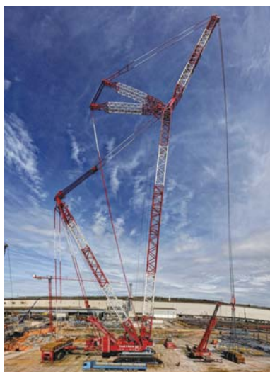
使用DILLIMAX的超级吊车承受的巨量负荷
